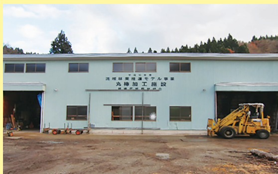
平成10年建設の丸棒加工所
