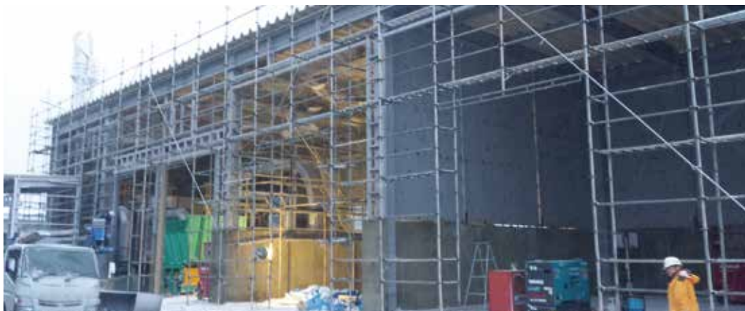
建設中の秋田基準寝具(株)湯沢工場のボイラー施設
